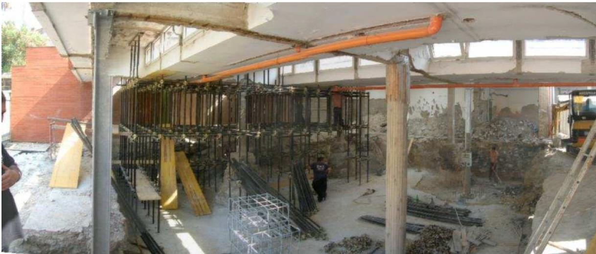
2. puntellamento della copertura, per effettuare la demolizione di pilastri e dei plinti in calcestruzzo;
