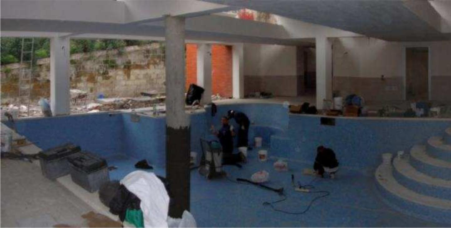
Le colonne in acciaio sono state inghisate nel calcestruzzo; fase di posa del rivestimento a mosaico
