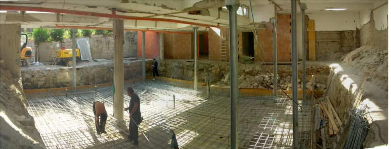
Successivamente le colonne in acciaio sono state inghisate in un getto di calcestruzzo, previa la posa di una armatura di ferri longitudinali e staffe, ottenendo in sostanza una struttura mista acciaio-calcestruzzo.
