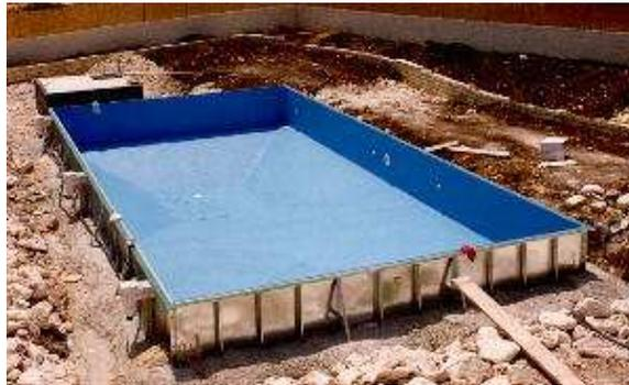
Esempio del montaggio di una piscina in prefabbricato di acciaio 7 X 14 H 1,05 profondità' 2,40 completa di tutto:
