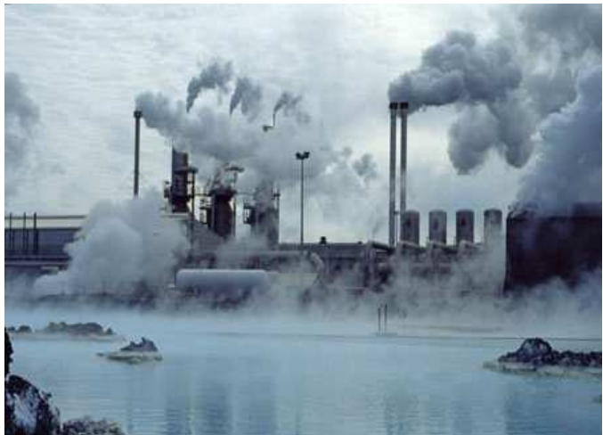
Una centrale elettrico-geotermica accanto a una sorgente geotermale.
